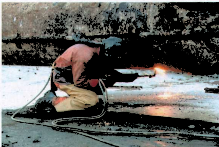
Figur 7: Brenning på rent stål (Foto: HT Smedbold).
